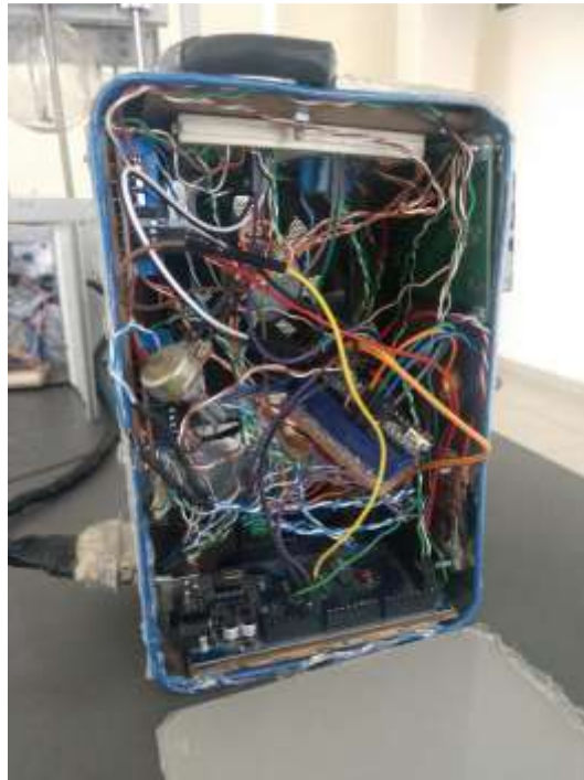
Figura 73. Interior de gabinete de panel de control.
