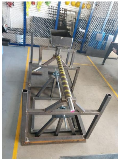
Figura 18. Construcción de la estructura de soporte: vista completa.
