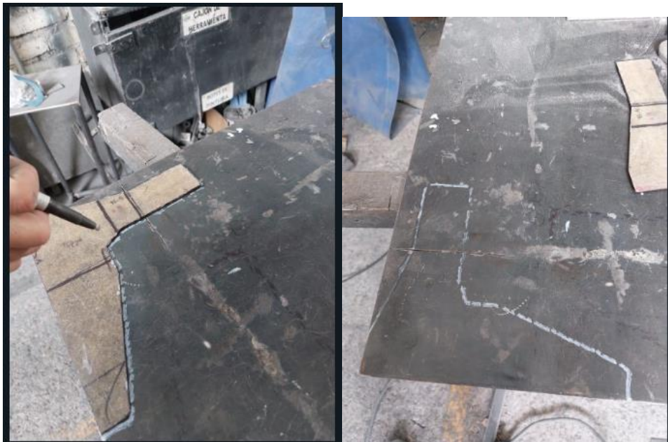
FIGURA 13 y 14: trazo de boceto con plantilla en la placa de \frac{1}{4} de pulgada
