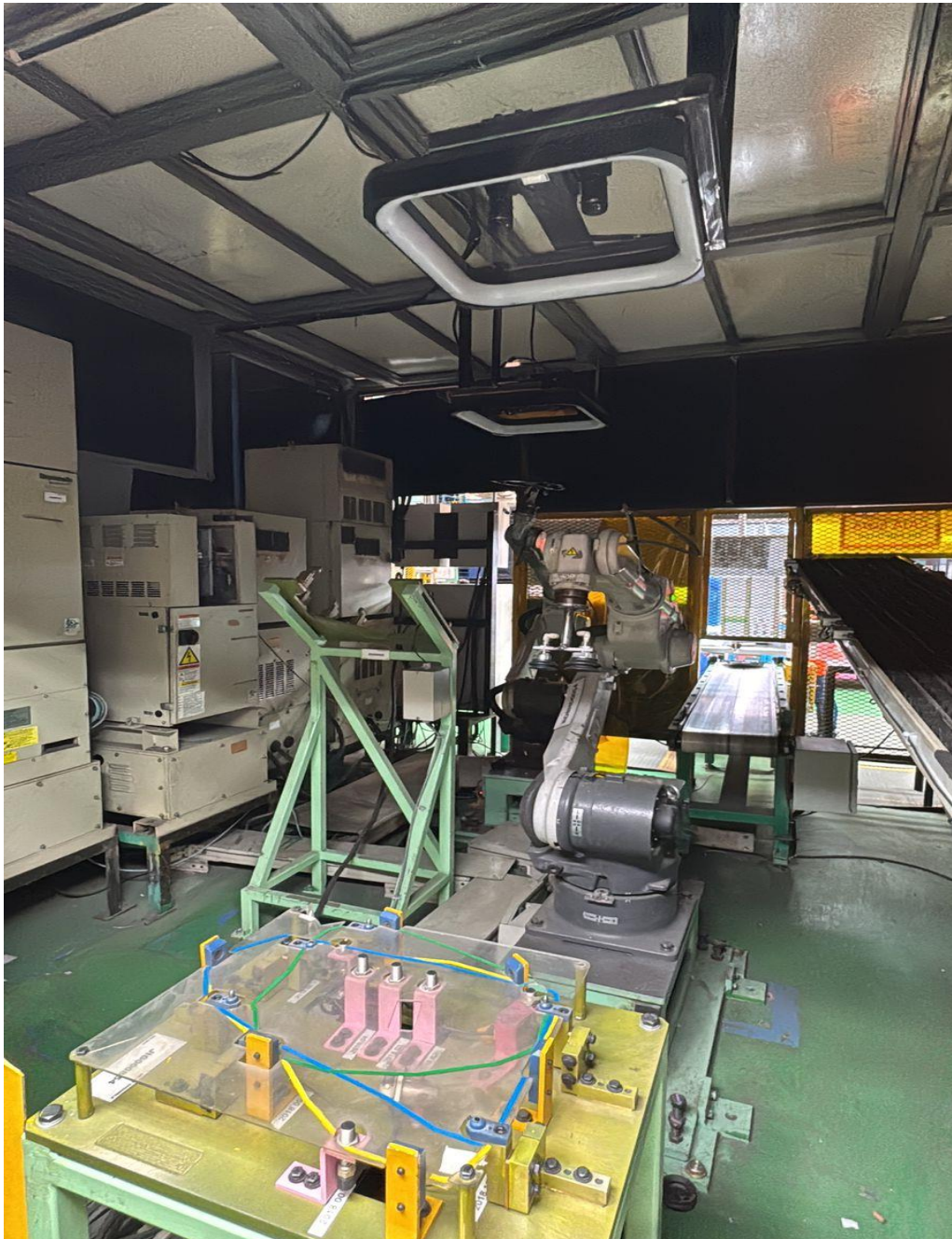
Ilustración 28.- Cabina Jatco Finalizada
