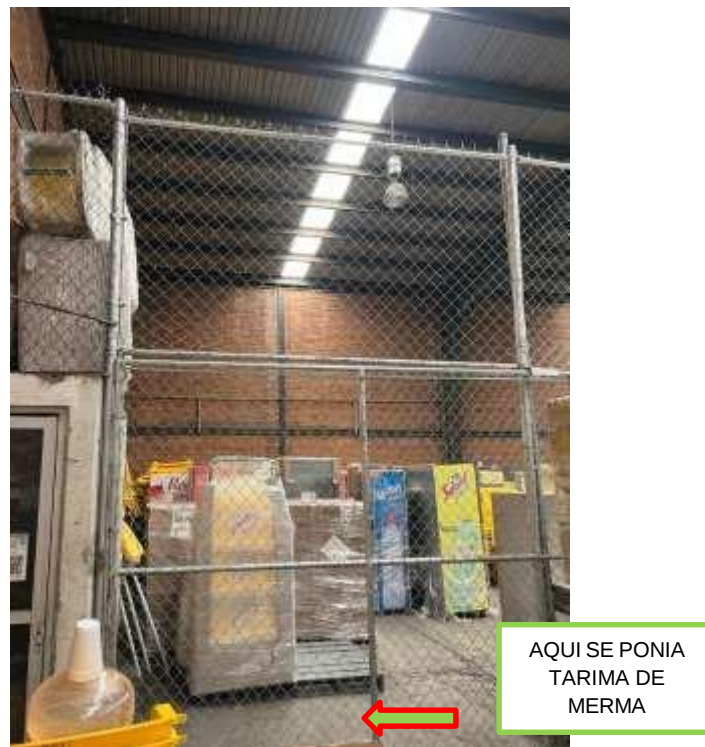
Figura 12.2 Área de refrigeración.
