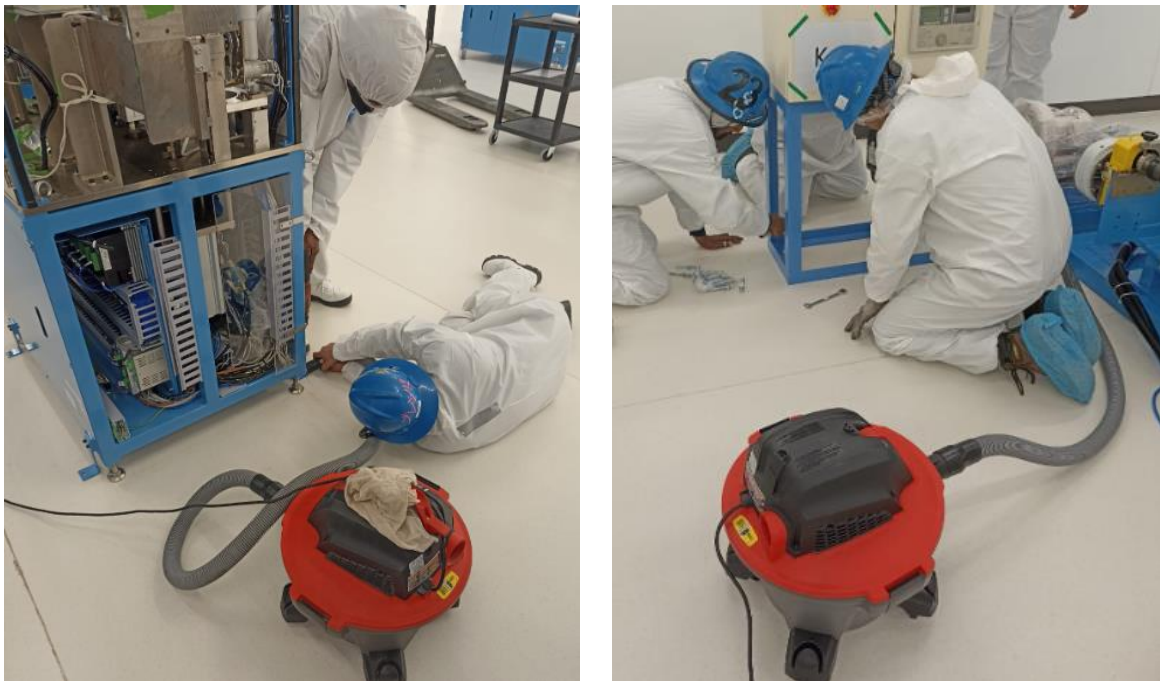
Ilustración 23 "Actividades de anclaje de máquinas" (Fuente: Judd Wire, 2024)
