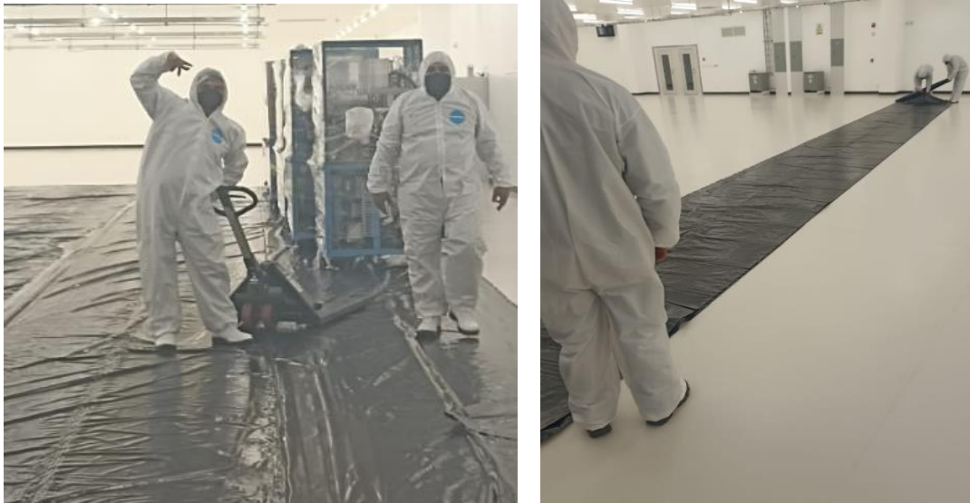
Ilustración 17 "Preparativos de zona de traslado de máquinas a posición final" (Fuente: Judd Wire, 2024)
