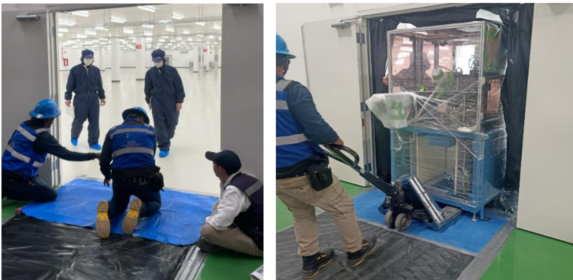
Ilustración 11 "Acondicionamiento para el acceso de máquinas a cuarto limpio" (Fuente: Judd Wire, 2024)
