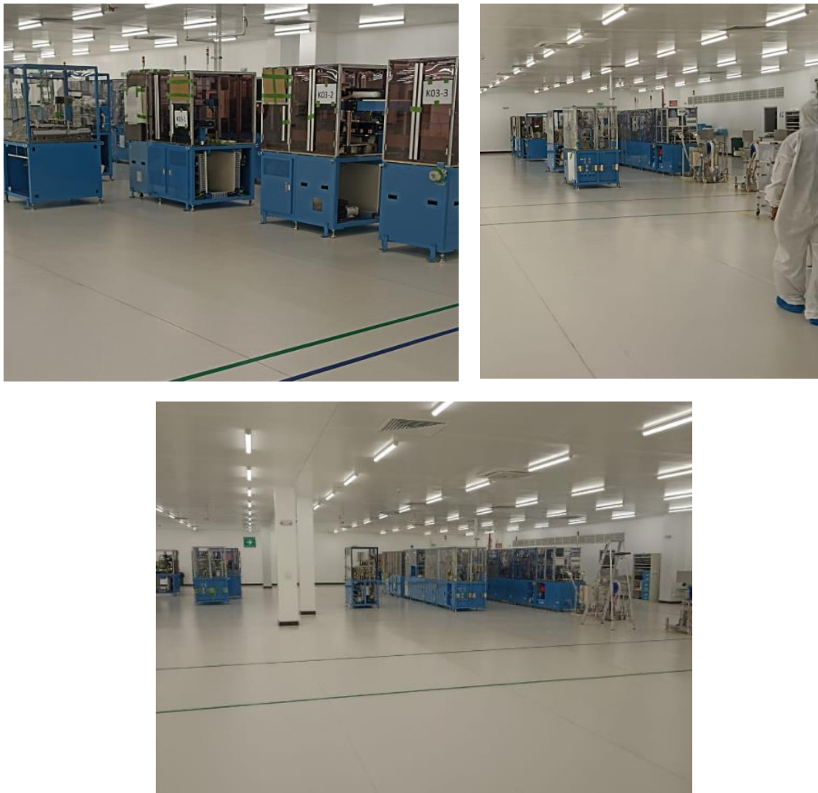
Ilustración 20 "Acercamiento de máquinas a posición final de instalación" (Fuente: Judd Wire, 2024)
