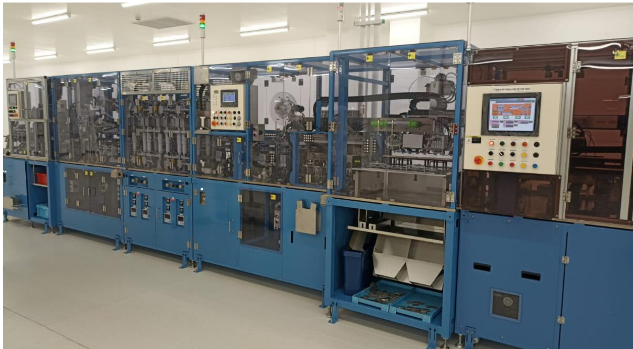
Ilustración 29 "Máquina Laminadora completamente instalada" (Fuente: Judd Wire, 2024)
