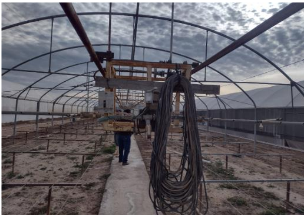
Imagen 4: equipo aéreo dañado
