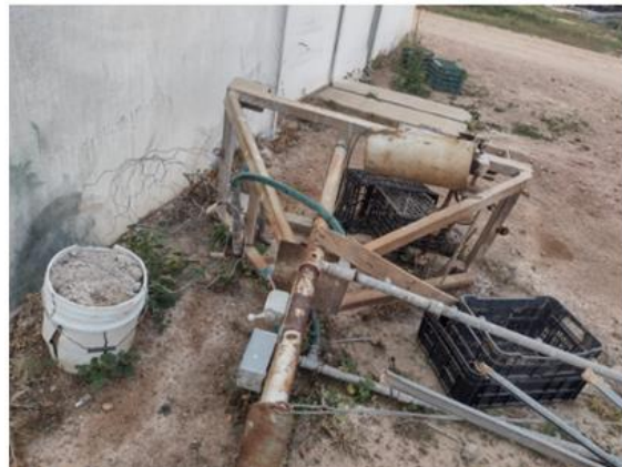
Imagen 3: equipo terrestre dañado
