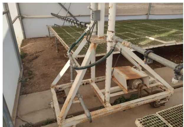
Imagen 21.1: equipo terrestre en funcionamiento
