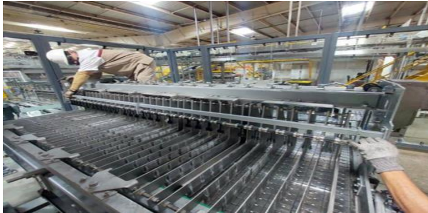
ilustracion 3.5. Colocar palometas y sensores
