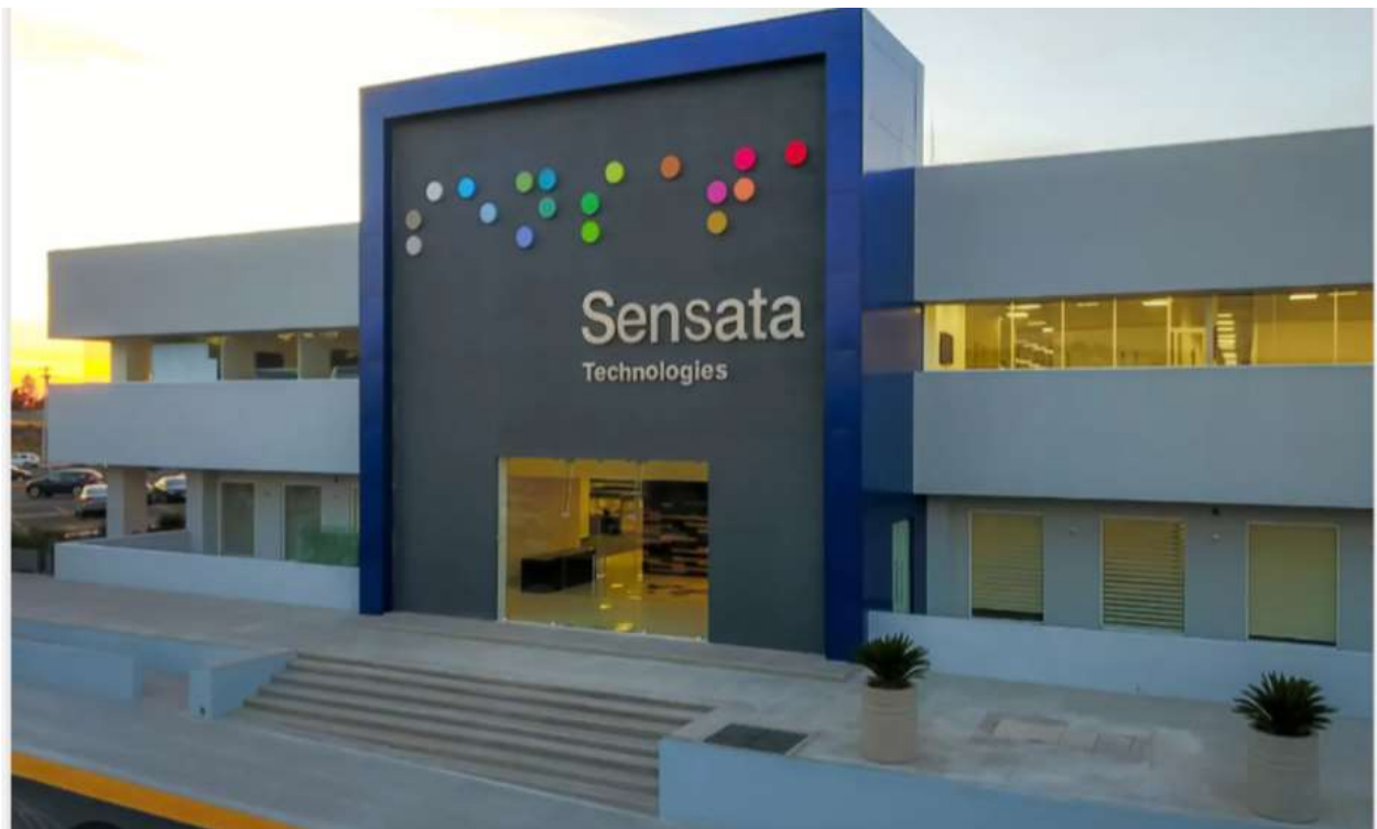
Figura 2.3 Edificio Central de Proyectos
