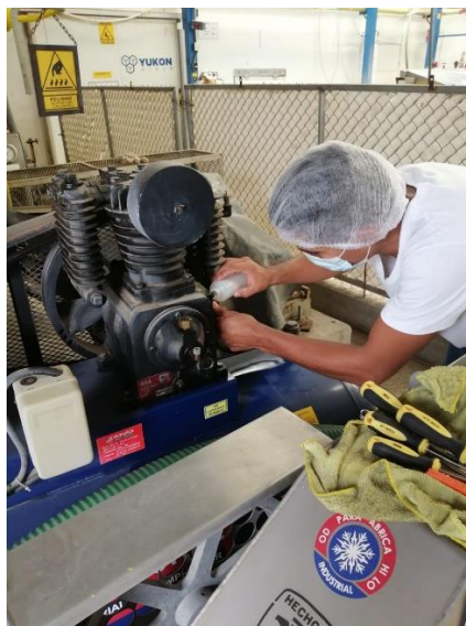
Figura 35 , mantenimiento 6 como podemos ver en esta imagen se estará lubricando la máquina de compresor para que siga teniendo buenas condiciones.
