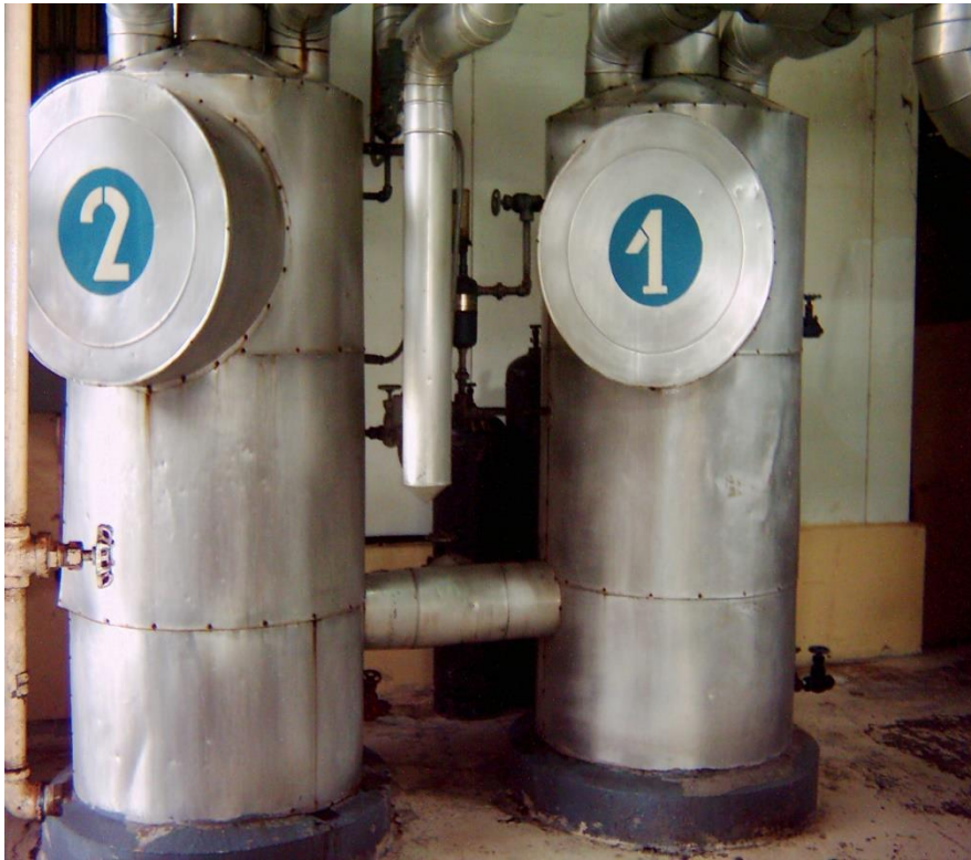
Figura 14. En esta imagen nos muestra las trampas de succión son dos tanques de aluminio conectados a tuberías.
