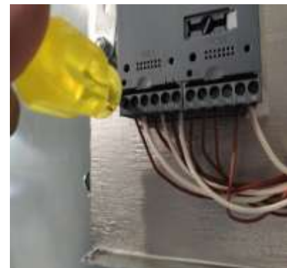
Figura 52. Conexión porta-fusibles del bloque X2 (Sentron PAC 3100).
