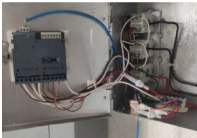
Figura 56. Ponchado de cable para coplee de la parte inferior.
