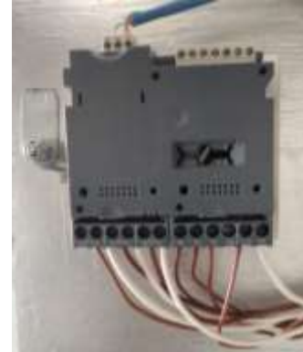
Figura 51. Conexión estrella de transformadores de corriente a Sentron PAC 3100.
