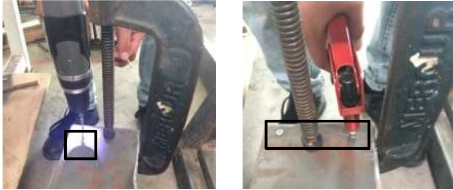
Figura 40. Perforación y colocación de remache para el gabinete eléctrico.
