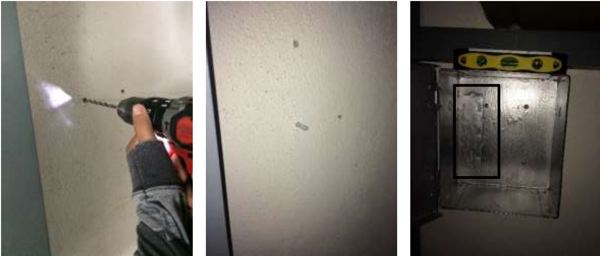
Figura 44. Instalación del gabinete de control a la pared.
