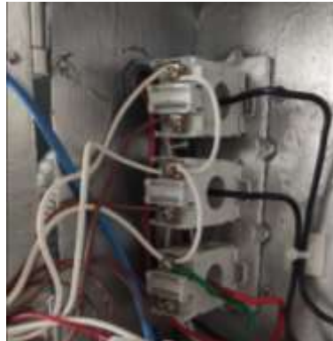
Figura 51. Conexión estrella de transformadores de corriente a Sentron PAC 3100.
