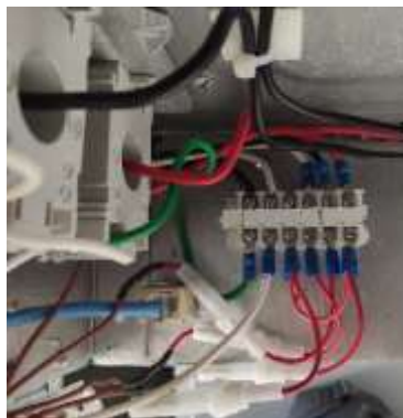
Figura 52. Conexión porta-fusibles del bloque X2 (Sentron PAC 3100).
