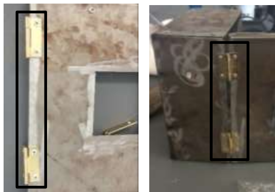
Figura 42. Instalación de bisagras para el sistema de apertura del gabinete.
