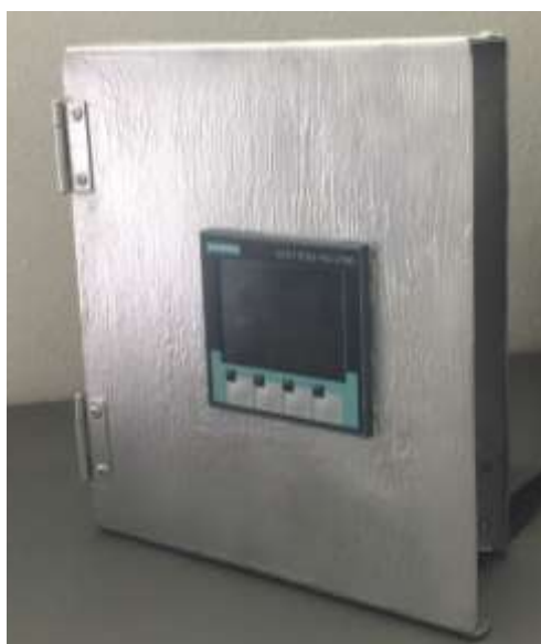
Figura 43. Resultado final del gabinete eléctrico con Sentron PAC 3100.
