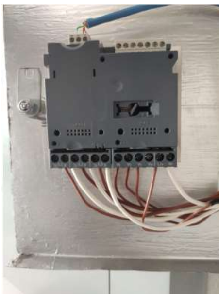
Figura 52. Conexiones del Sentron PAC 3100.
