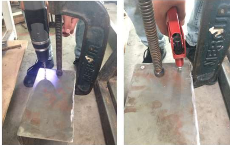
Figura 41. Remachado del gabinete.
