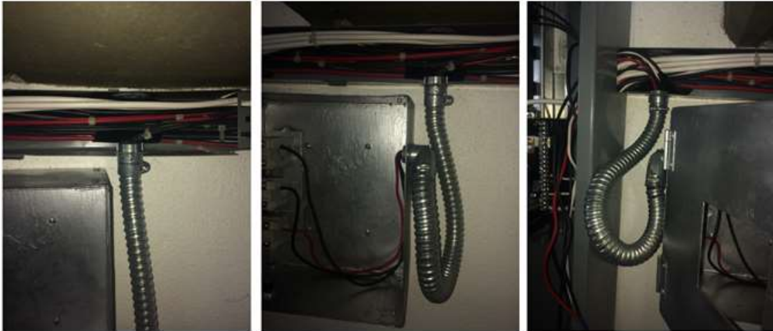
Figura 50. Ruteo para la entrada y salida de cables en el gabinete.
