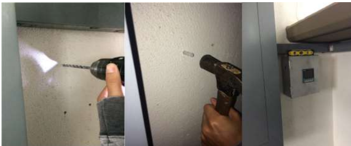
Figura 46. Empotramiento del gabinete.
