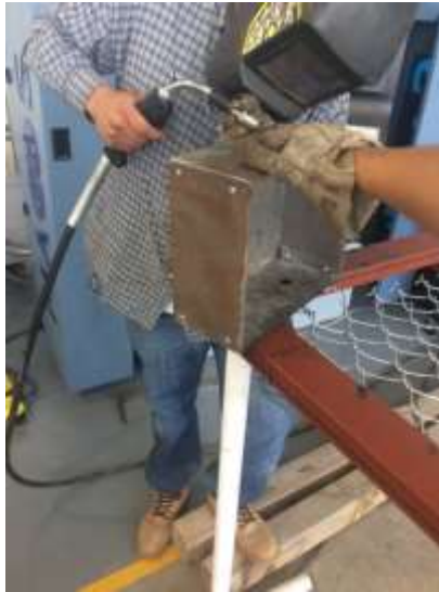
Figura 43. Proceso de soldadura.
