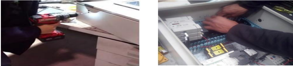
Figura 18 y 19 - Instalación de Canaletas, Guías y realización de perforaciones para componentes y cableado.
