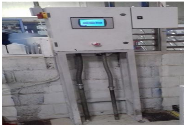
Figura 62 - Colocación final del tablero de control nuevo.
