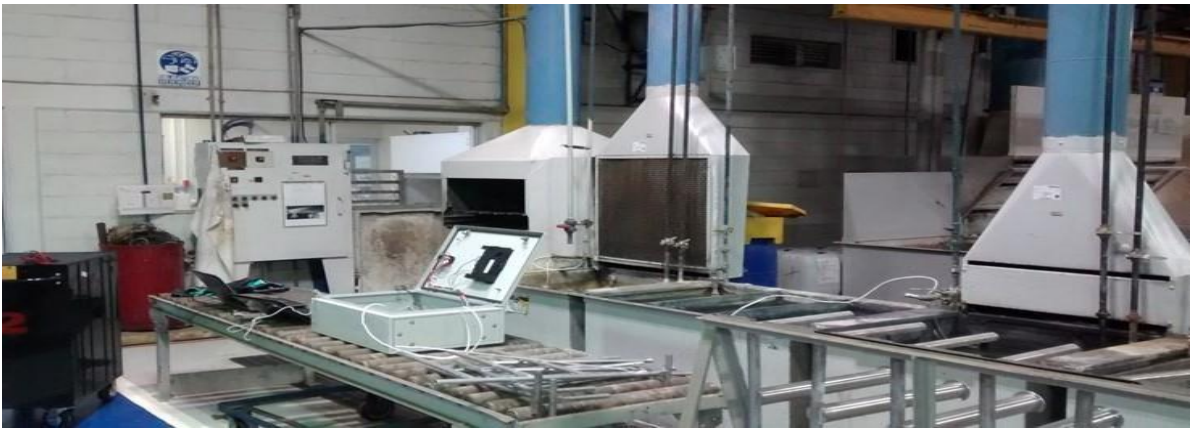
Figura 59 – Monitoreo del PLC y Pruebas para la calibración de los sensores.
