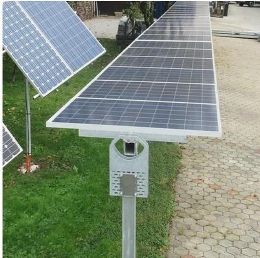
**Figura 7.** Seguidor solar en un eje [12].
