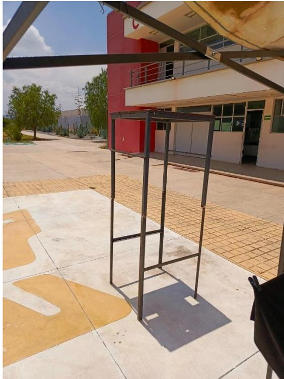
**Figura 23.** Preensamble de los soportes de la base de la torre.
