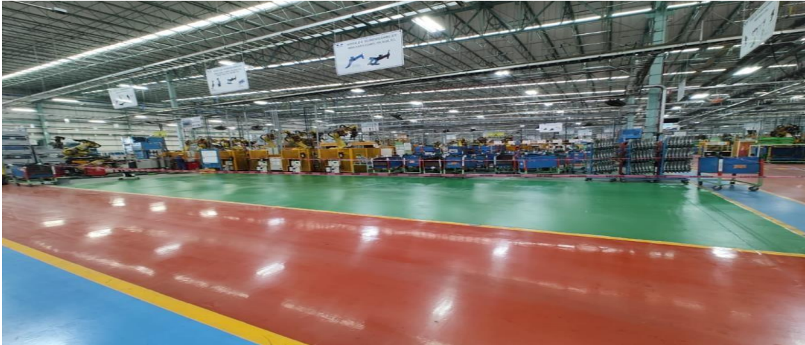
FIGURA 27. FOTOGRAFIA DEL ESPACIO DESOCUPO PARA REINSTALACION DE LINEA.
