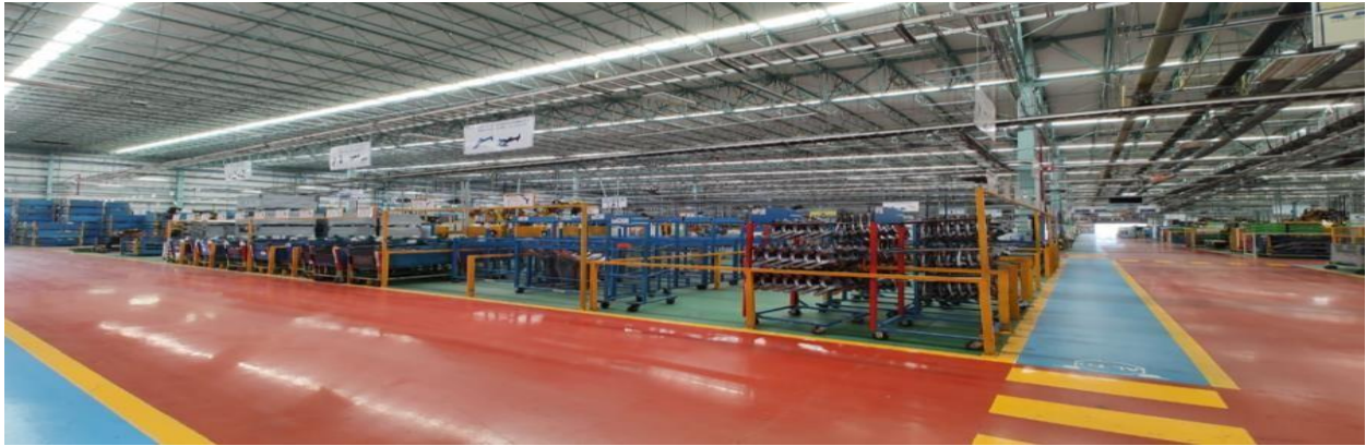
FIGURA 25. FOTOGRAFIA DEL ESPACIO PARA LA REINSTALACION DE LINEA.
