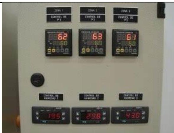
*Ilustración 7.- Sistema de control de temperatura y humedad*
