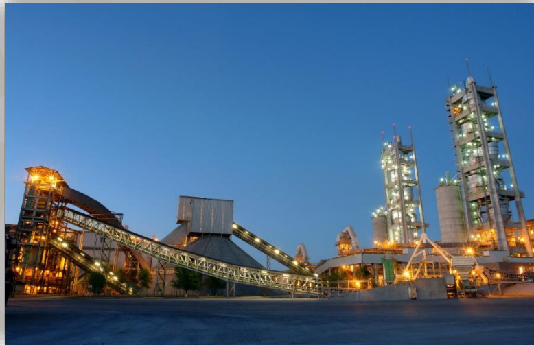
Figura II.1 CYCNA de Aguascalientes. Fuente: CyCNA. 2023
