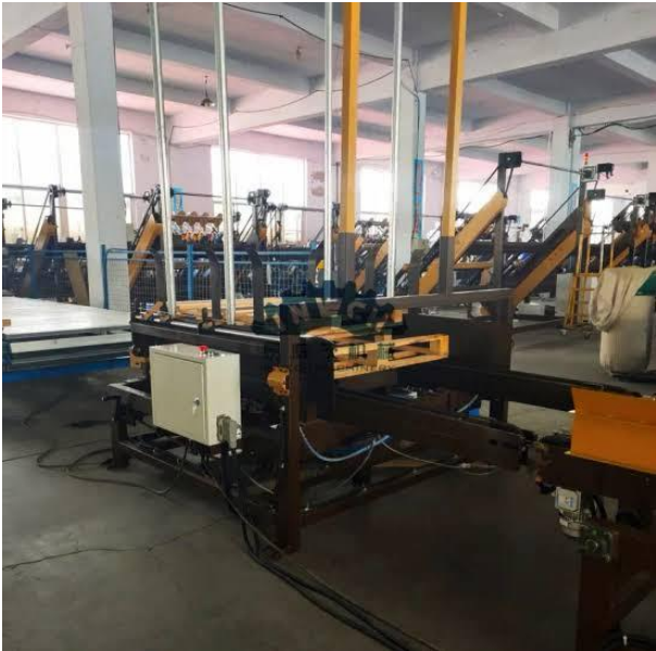
Ilustración 0-15 Maquinaria que requirió reparación. Elaboración propia, 2024
