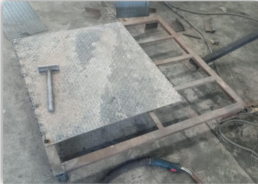
Figura 104: Alineación y punteo de placas. Fuente: (TTSA, 2023)
