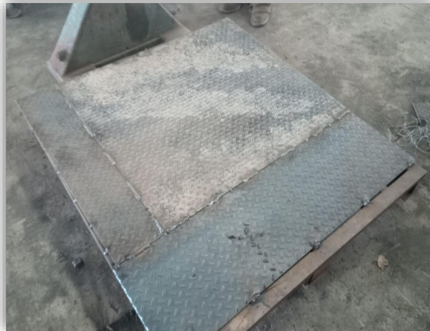
Figura 131: Cordones seccionados de soldadura a toda la tarima. Fuente: (TTSA, 2023)
