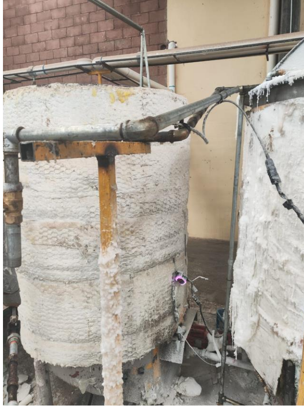
Ilustración 9. 11 Tubos para Termómetros 2. Fuente: Elaboración Propia. 2024
