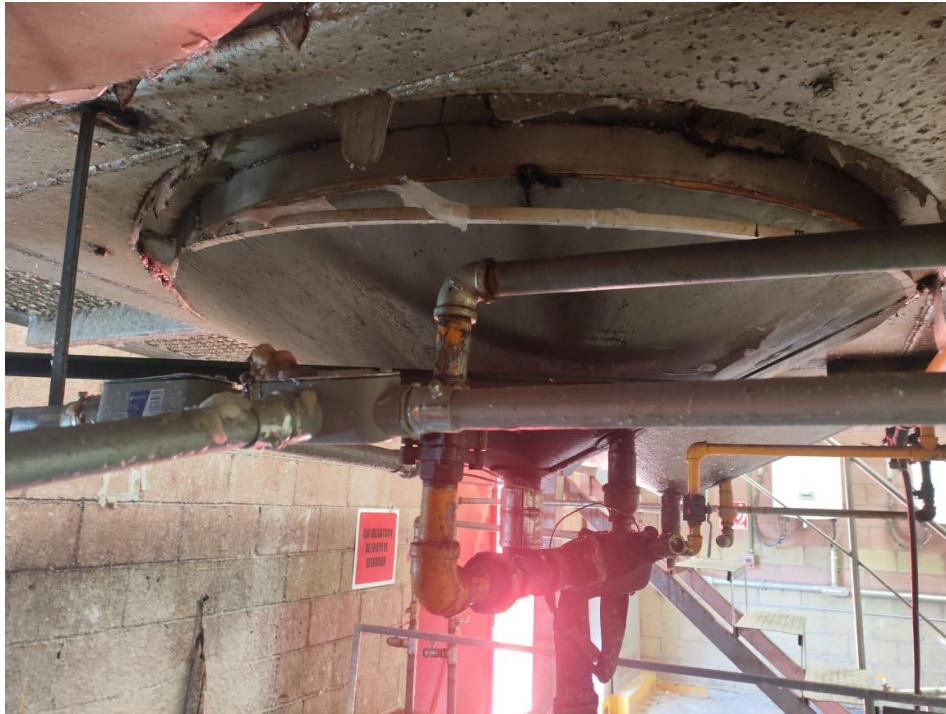
Ilustración 9. 10 Tubos para Termómetros. Fuente: Elaboración Propia. 2024
