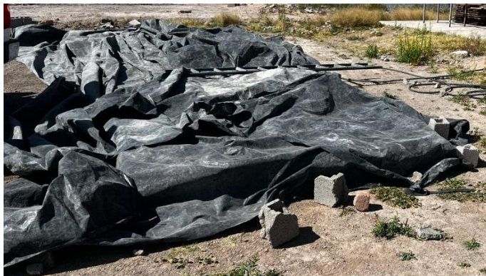
Figura 19. Tapado de blocs para fraguado
