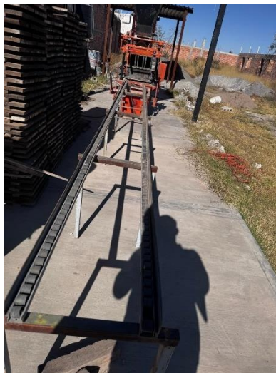
Figura 22. Estructura metálica (banda)
