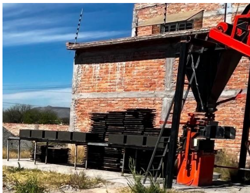
Figura 17. Llenado de banda de tarimas con blocs
