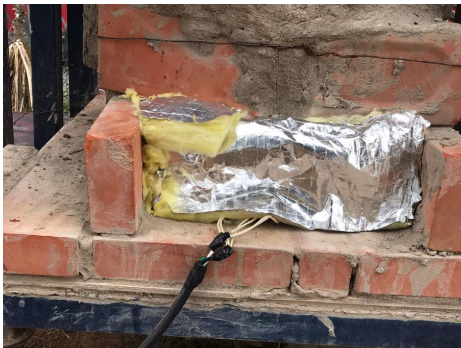
Figura 13. Aislamiento de sistema de calentamiento: inicio de prueba.
