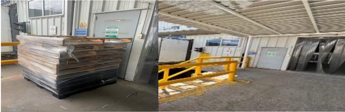
Ilustración 25, Rampa de Servicio Obstruido, Elaboración Propia.
