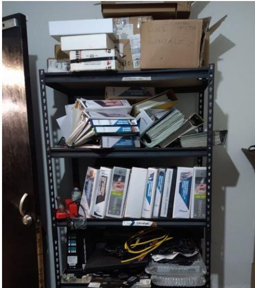
Figura 4. 11 Antes del rack 1
