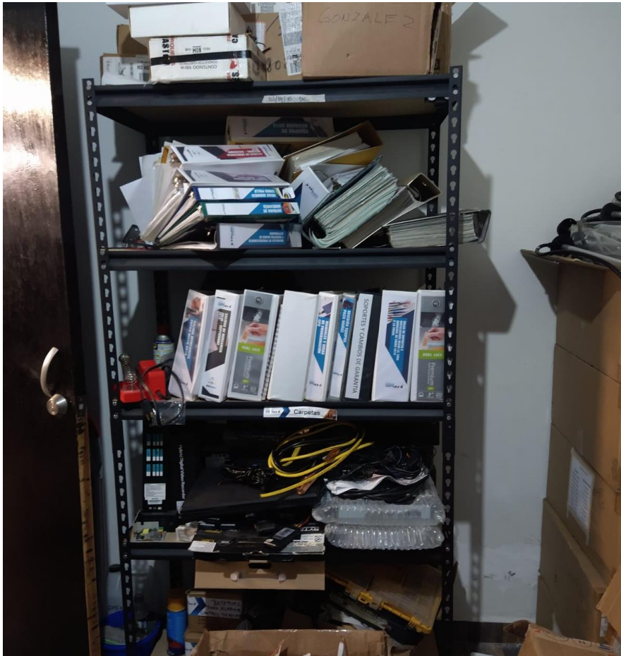
Figura 5. 2 Antes del rack 1
