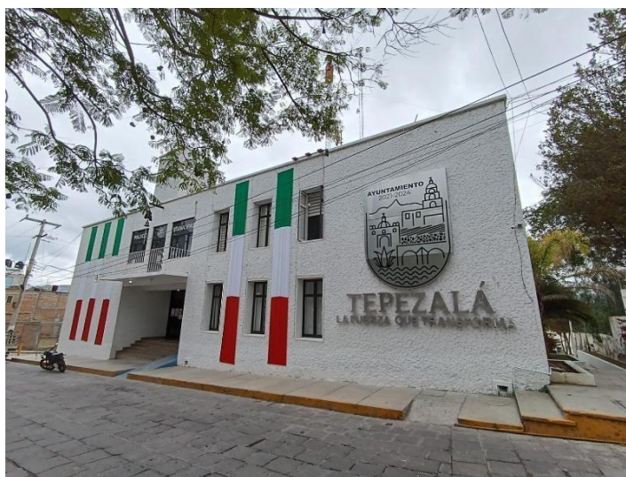
Figura 2.2.2 Instalaciones de Presidencia Municipal de Tepezalá 2024
