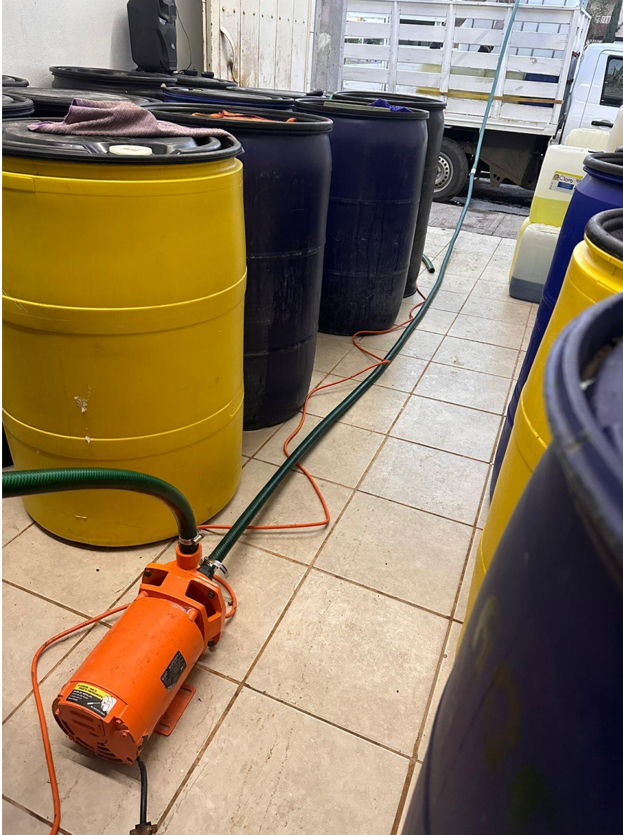
Ilustración 18. Descarga del proveedor con el material
