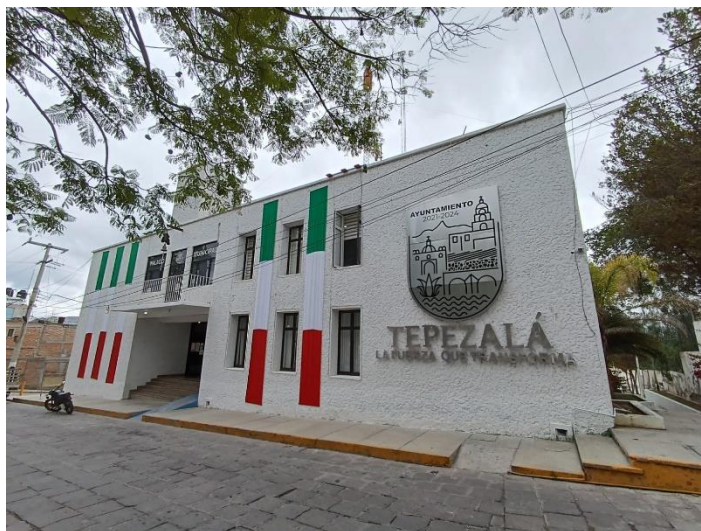
Figura 2.2.2 Instalaciones de Presidencia Municipal de Tepezalá 2024
