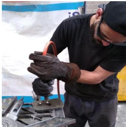
*Ilustración 11.- Ajuste de barreno con turbina neumática.*
