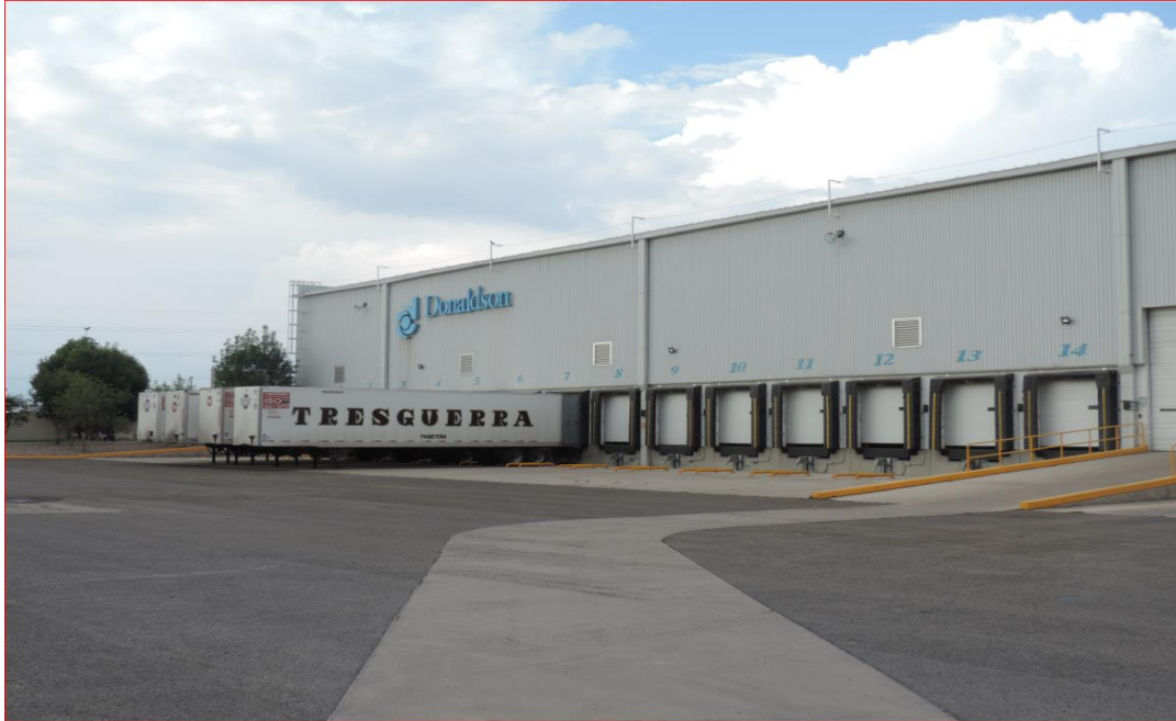
Andenes de carga Nacional rampa 1-14
