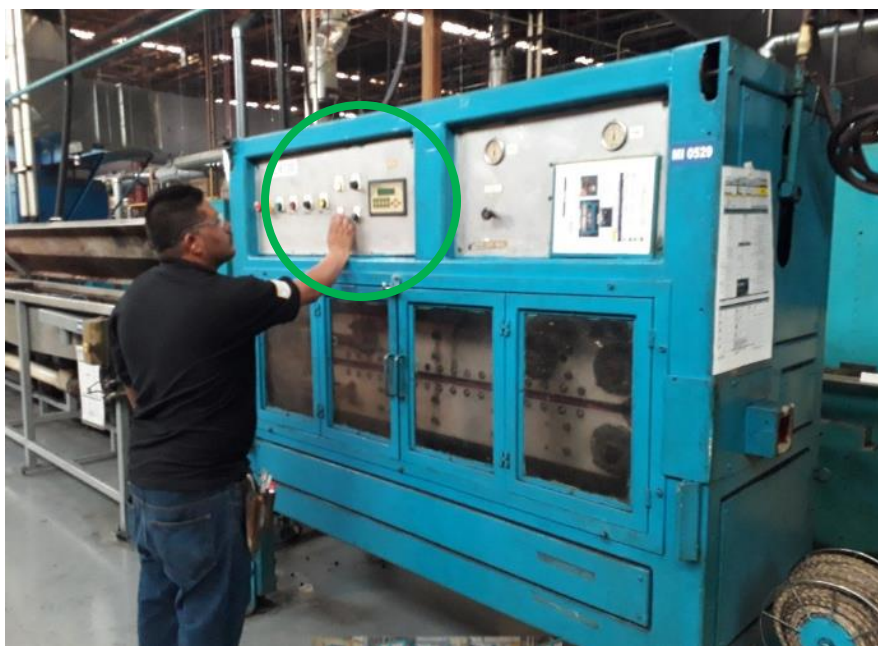
Ilustración 106, programando velocidad de puller o jalador.
