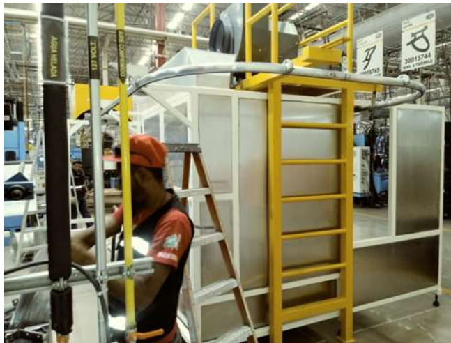
Imagen 27. Instalación del horno de curado
