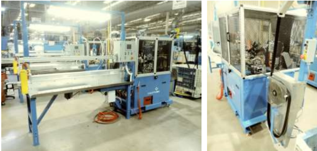
Imágenes 25 y 26. Instalación del equipo y herramental adquirido
