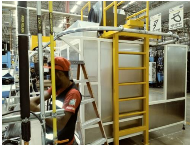
Imagen 27. Instalación del horno de curado
