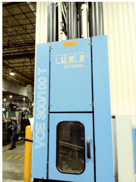
Imagen 34. Falta de HOE en la maquinaria
