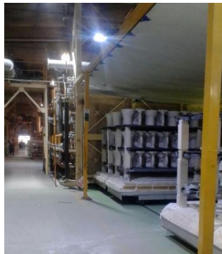
Imagen 60. Colocación de lámparas de led en inter.
