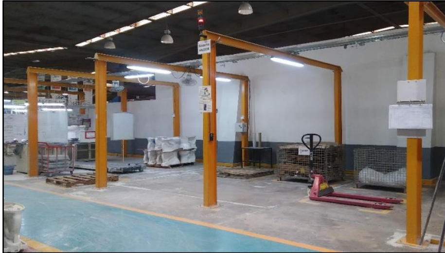
Imagen 56. Área de estibado del material resanado.
