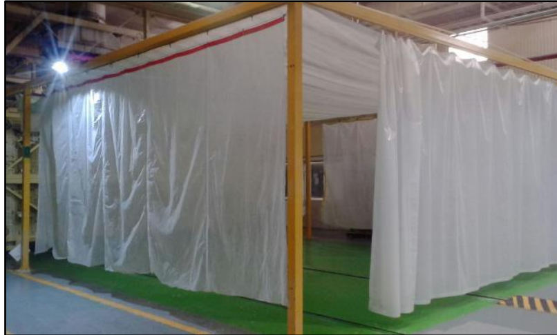
Imagen 62. Cortinas en inter completas.
