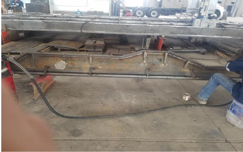
Imagen 4. Armado de vigas manualmente, parte de colocar atizadores para evitar que se mueva el alma con la solera
