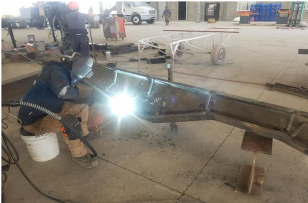
Imagen 3. Proceso de armado de viga manualmente, soldado en forma de cordón del alma con la solera
