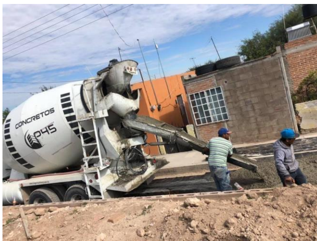
Figura 1: Tirado de concreto
