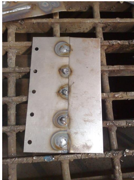
Ilustración 10 Punto de soldadura
