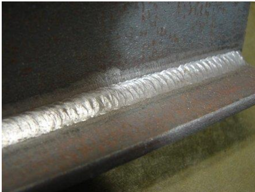
Ilustración 9 Cordón de soldadura
