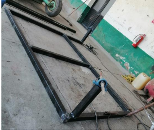
Ilustración 50. Construcción de estructura
