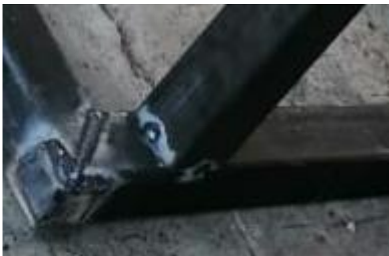
Ilustración 51. Refuerzos soldados a la maquina
