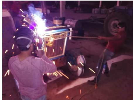
Ilustración 57. Proceso de soldadura a base del tractor.
