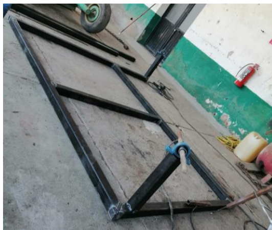
Ilustración 50. Construcción de estructura
