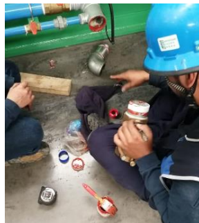
Figura 78 Cambio de Tubería
