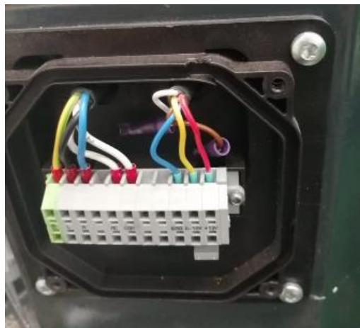
Figura 58 Encoder motor trifásico 440v.
