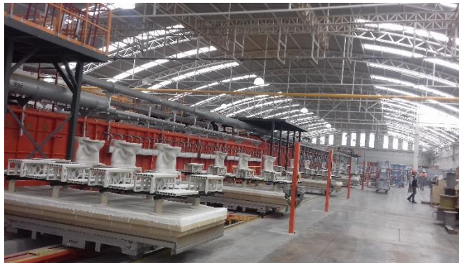
Imagen 3. Vagonetas sin protección de polvo
