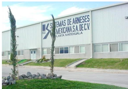
Figura 7. Instalaciones K&S Mexicana, Matehuala, S.L.P.
