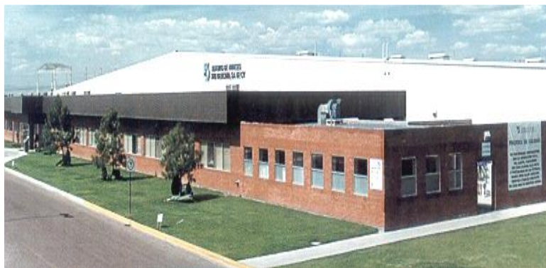
Figura 4. Instalaciones K&S Mexicana, S.F.R, Ags.
