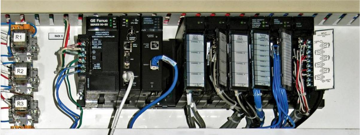
Figura 5. Imagen de un PLC en físico.
