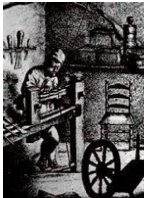
Figura 2. Torno de pedal y pértiga flexible.
