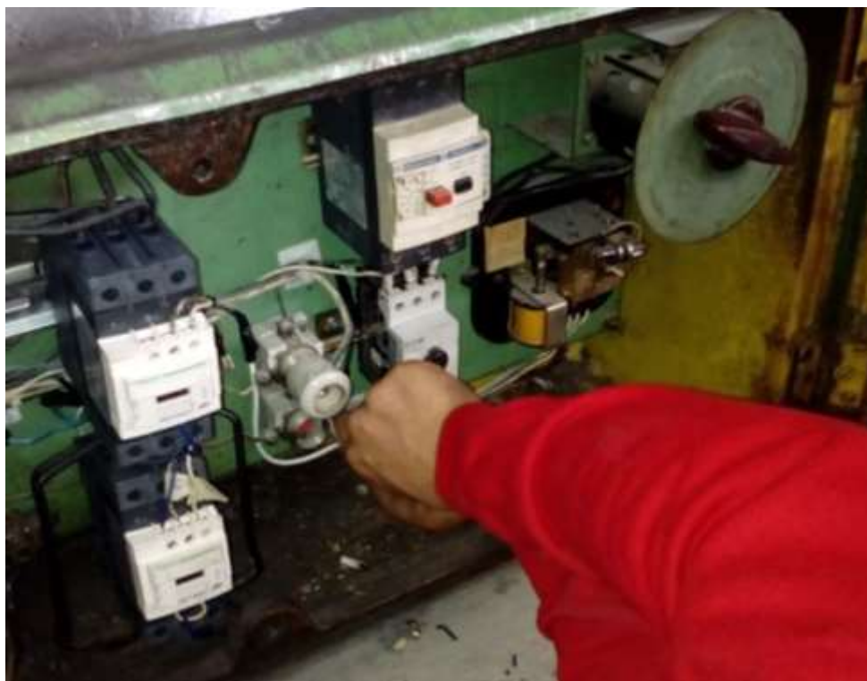
Fotografía 14. Máquina para realizar máquinados complejos. (Relevadores Térmicos Nuevos)
