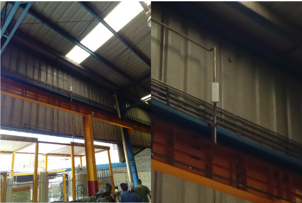
Figura 3.3 Repetidor instalado correctamente
