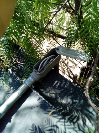
Figura 3.1 Cableado de Internet para PC en taller de fabricación.
