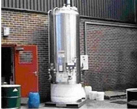
*Ilustración 20. Tanques usados para almacenar hidrogeno líquido. (Xaudaró, 2011)*
