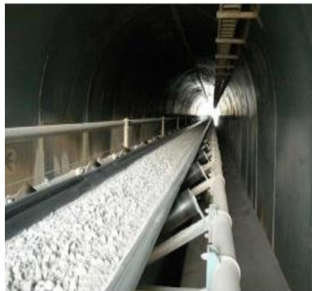
Fig. 2 Cinta transportadora de acopio de hormigón
