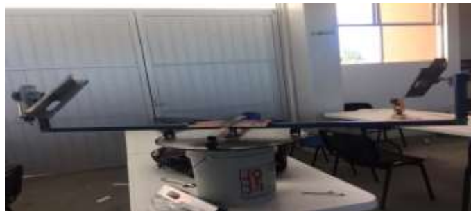
Figura 11. Avance de instalación
